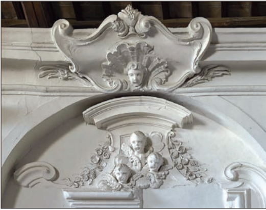
Resti dell'altare barocco dedicato a Santa Margherita, smantellato negli anni '60 del secolo scorso in occasione di alcuni dei lavori di ristrutturazione.
